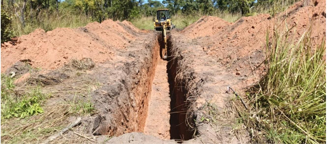
**Figure 38 Ouverture du tranché dans la partie superficielle (zone d 'excavation)**
